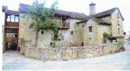
FIG. 1 - Aspect extérieur du musée ; à gauche son extension de 1998. (Photo G. Marsan).
